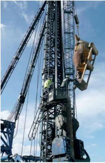
Figuur 3: Het kubelen van de betonmortel in de stalen casing
