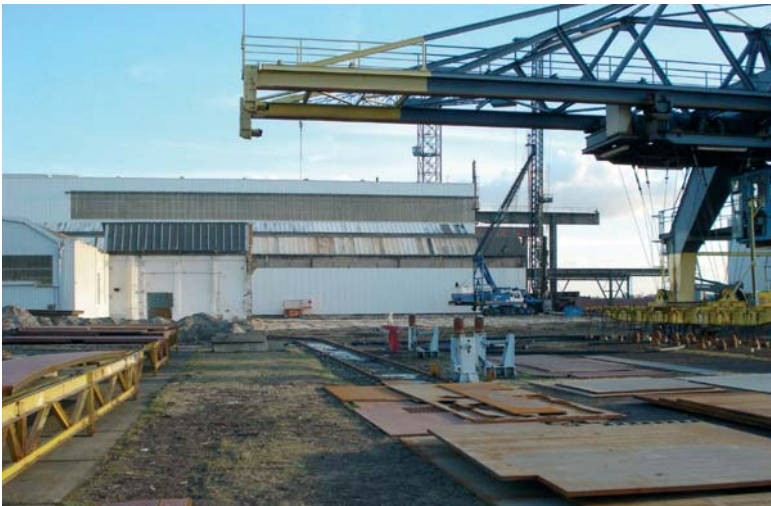
Figuur 5: Heiwerkzaamheden hal 10
