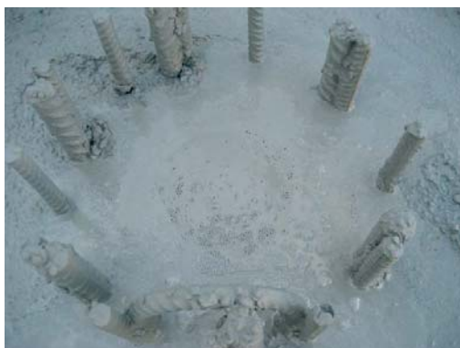
Figuur 6: Optredende welvorming door het midden van de paal (foto links en rechts)
