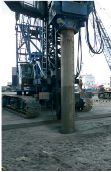
Figuur 4 (rechts): Het uittrillen van de casing, nadat de paal gereed is
