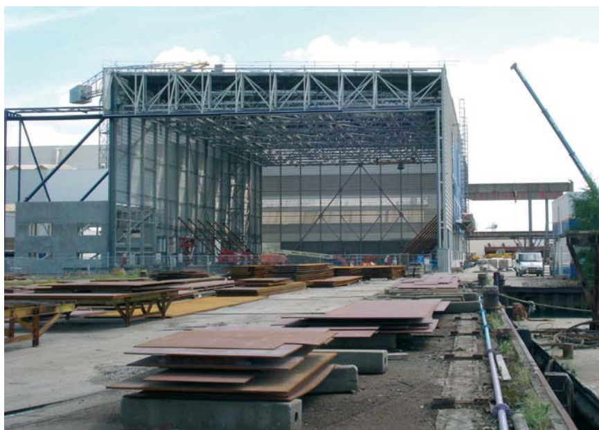
Figuur 9: Hal 10 Hollandia in aanbouw
