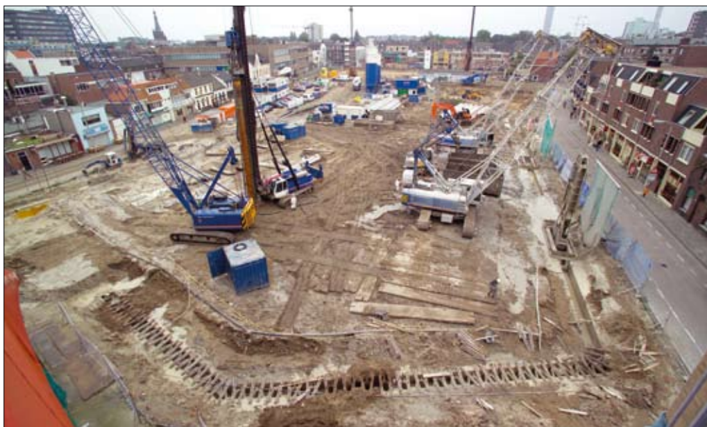
↑ Figuur 1 Overzicht van de bouwplaats
