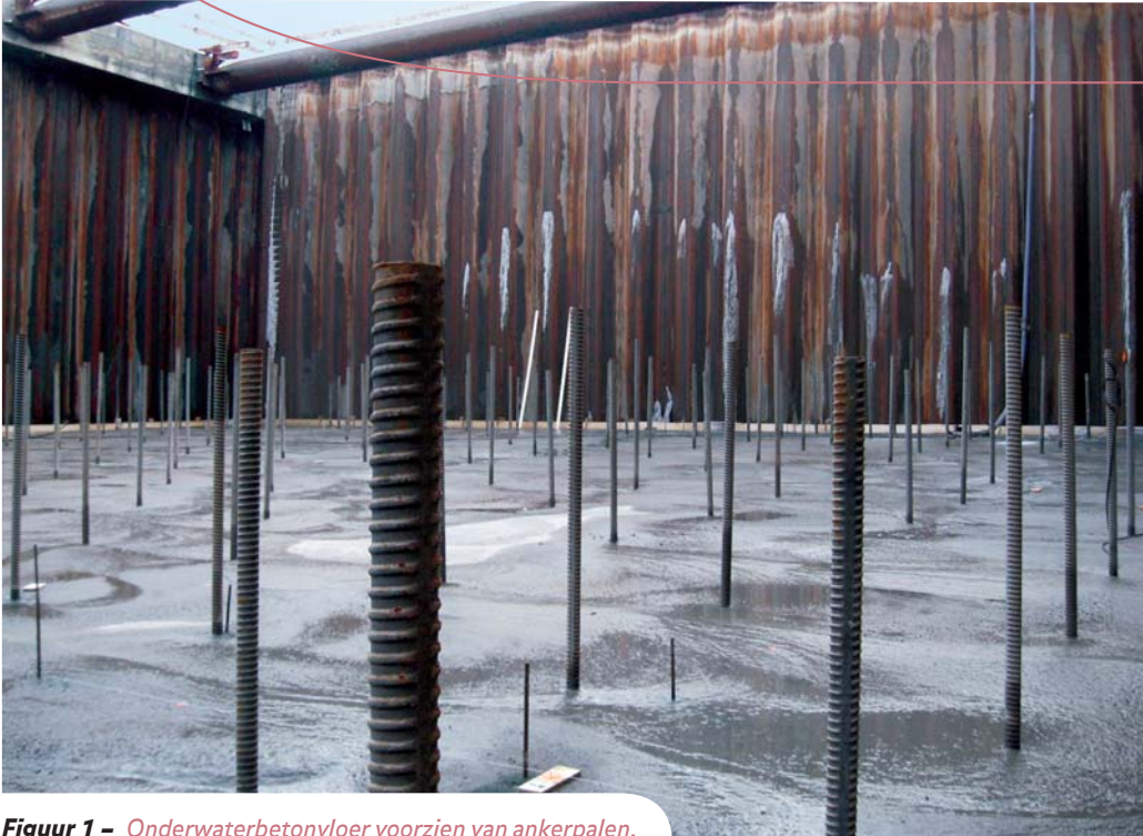
Figuur 1 – Onderwaterbetonvloer voorzien van ankerpalen.
