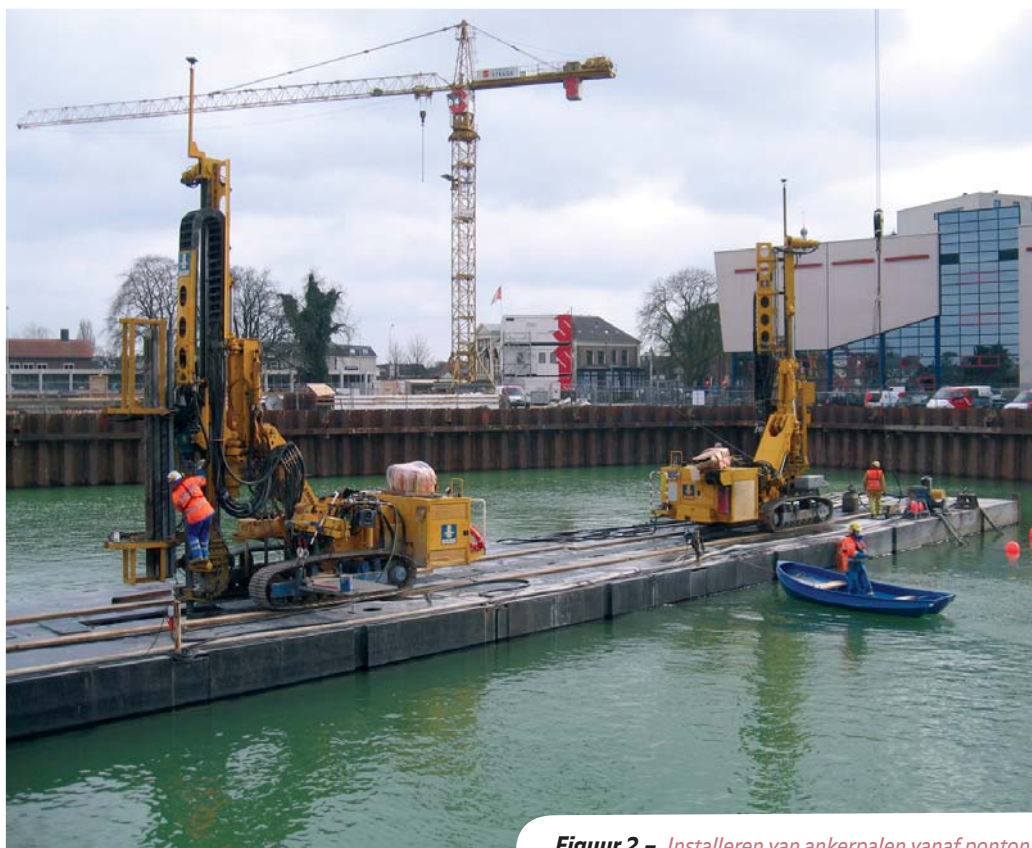
Figuur 2 – Installeren van ankerpalen vanaf ponton.
