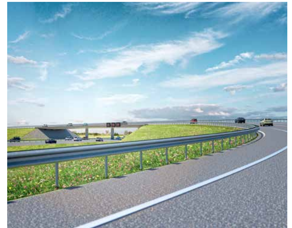
Knooppunt De Liemers vormt straks de schakel tussen de bestaande A12 en het nog aan te leggen gedeelte van de A15.
